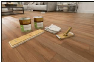
Une légère friction du papier à sabler sur le plancher est recommandée. Cette action aura pour effet de briser la surface polie du plancher dans les zones achalandées. Après un léger sablage, nettoyer les zones à restaurer de 2 à 3 fois à l'eau tiède avec une vadrouille bien essorée. Par la suite, laisser sécher et commencer l'application d'une fine couche d'Huile de finition satinée.
